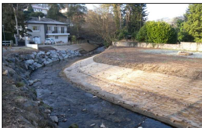
Après : Abattage des résineux, retalutage, techniques végétales (en cours)
