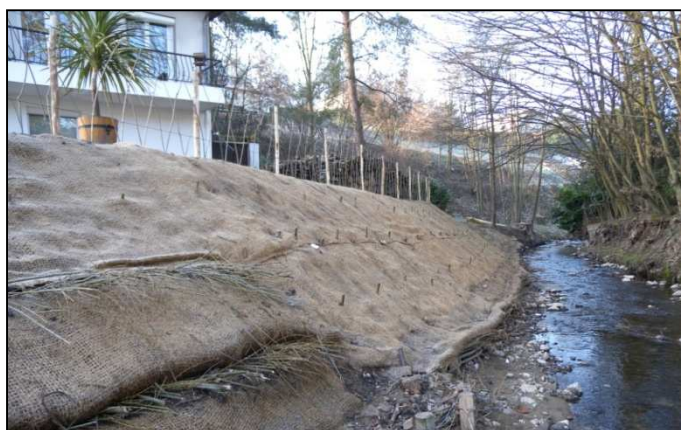
Après : Arrachage de la haie, retalutage, techniques végétales
