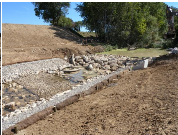
Photo 1 : Ouverture de la Mosson et pose de la canalisation
