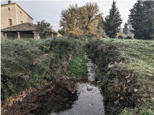
Post travaux (*Suppression des merlons, retalutage en pente douce, suppression des enrochements*)
